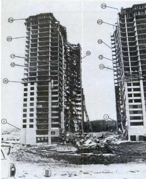
Gambar 1 Bangunan Skyline Plaza Setelah Keruntuhan (Leyendecker & Fattal, 1977)
