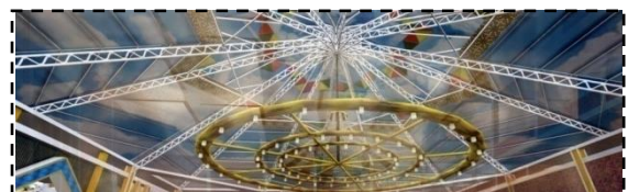
Gambar 3.25. Struktur Bangunan Masjid
