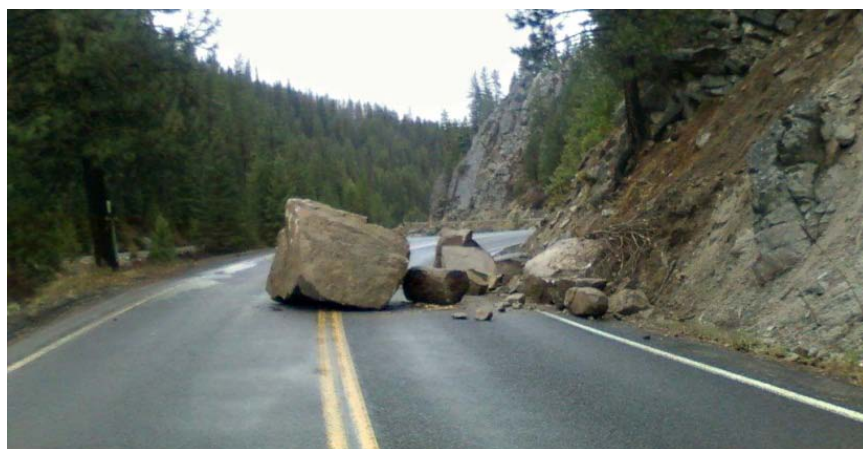
Gambar 1 Jatuhan batuan yang terjadi di Idaho, Amerika. ( Sumber : Idaho Transportation Media Manager )
