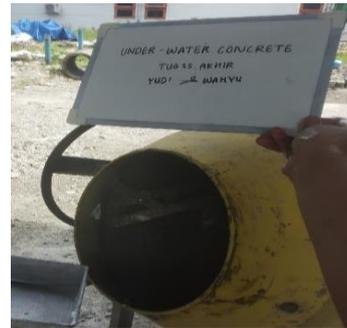
Gambar 3. Pencampuran adukan dalam *concrete mixer*
