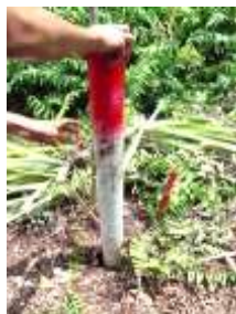
Gambar 5. Memasukkan Kembali Pipa PVC Setelah Bersih
