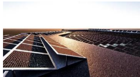
Gambar 17. Solar panel pada atap bangunan
