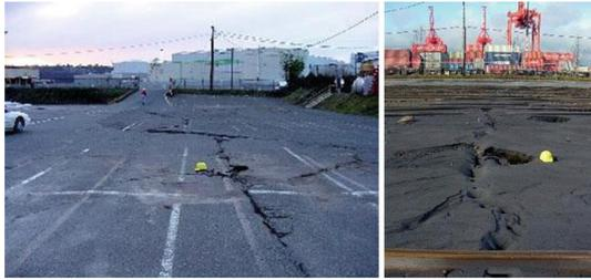
Gambar 3. Retakan-retakan pada Tanah (*Ground Cracking*)
