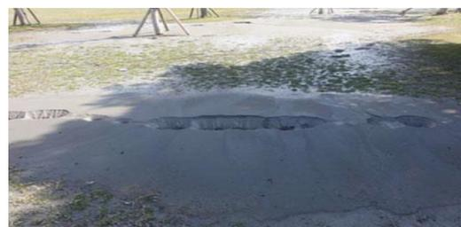
Gambar 2. Semburan Pasir (*Sand Boiling*)
