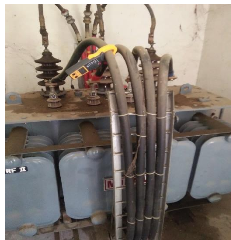
Gambar 4 Pengukuran arus penghantar netral (Fitriyanto, 2019)
