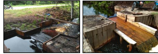
Gambar 1. Sekat Kanal ( Canal Blocking )
