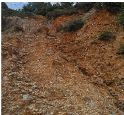
Gambar 3. Tampak depan lereng
