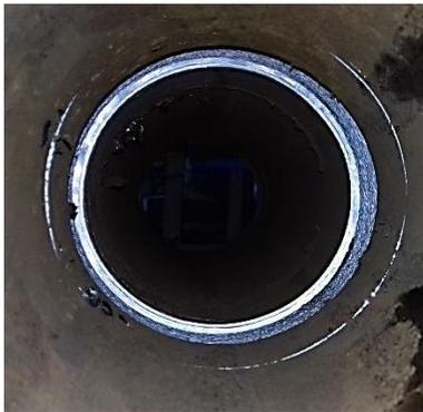
Gambar 4 Permukaan Pipa Kondisi Korosi 3
