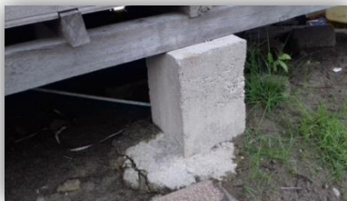
Gambar 2 Pondasi Tapak gajah
