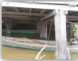
Gambar 1 Pondasi Cerocok atau Pancang
