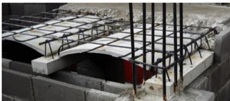
Gambar 2 Precast Pendukung Pelat (Support Beam)
