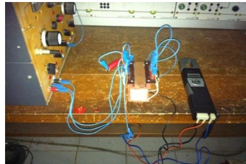
Gambar 4.18 Pengujian hubung singkat transformator tiga fasa
