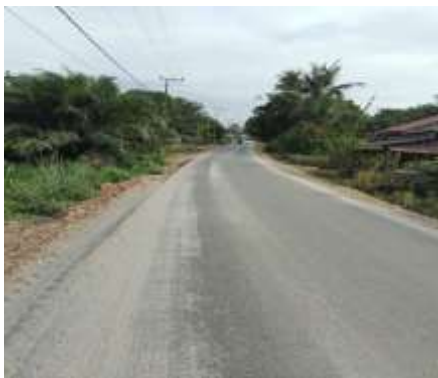
Gambar 1. 2 Jalan Desa Dusun Tua Pelang
