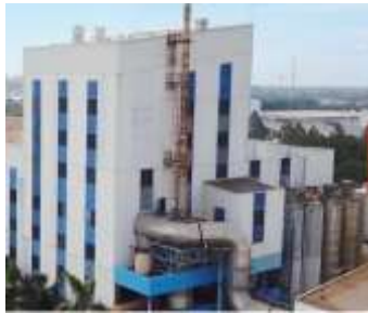
Gambar 2. Pemasangan Drying Tower oleh PT Unilever Indonesia
