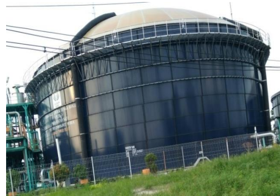
Gambar 1. Pembangkit listrik tenaga biogas (PLTBg) PT. Inti Indosawit Subur
